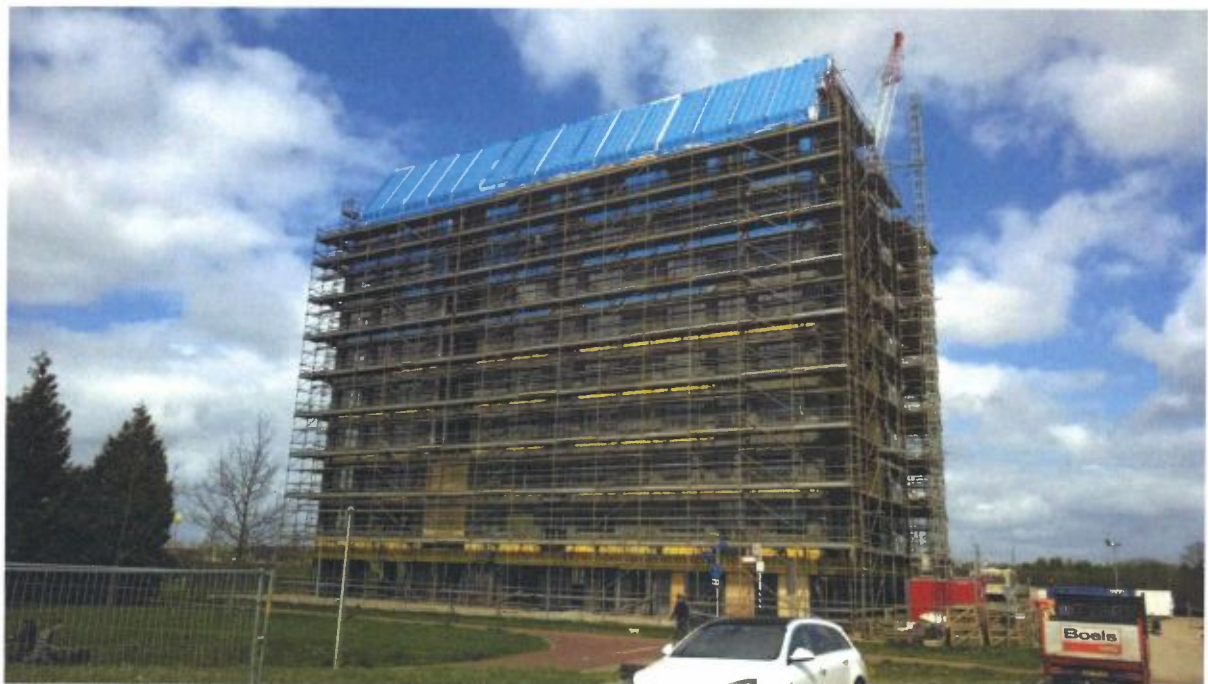
Messchenstaete in aanbouw, april 2016
