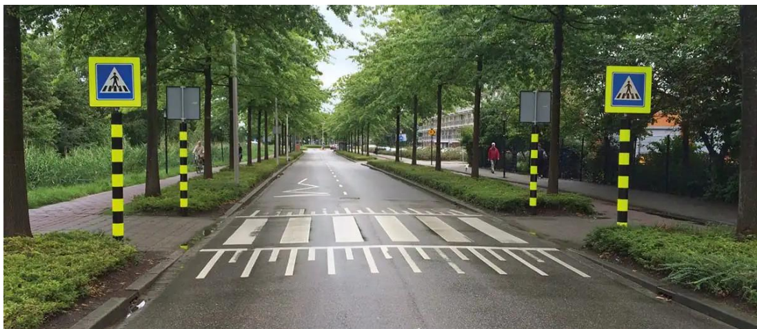
Figuur 7: Attentiepalen met reflecterende folie verduidelijken de ligging van het zebrapad (Foto: Pol Heteren)
